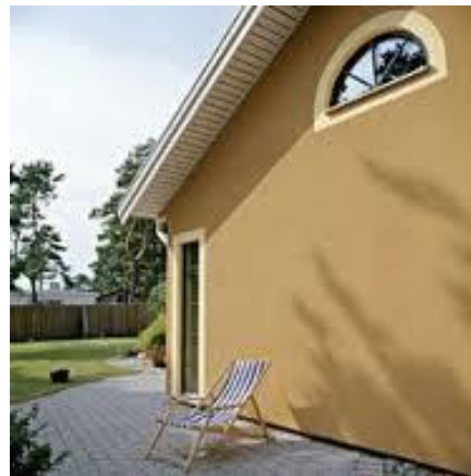
Var finns fuktriskerna i detta hus?
