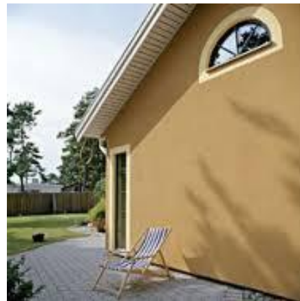
Var finns fuktriskerna i detta hus?
