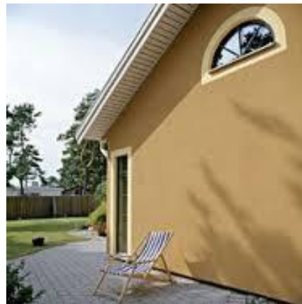
Var finns fuktriskerna i detta hus?
